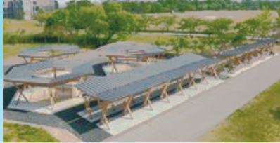
屋根付き駐輪場整備(平成27年)
